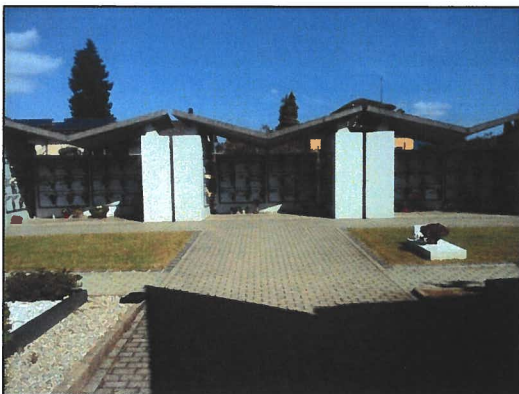
Foto 1 - Vista frontale loculi esistenti
