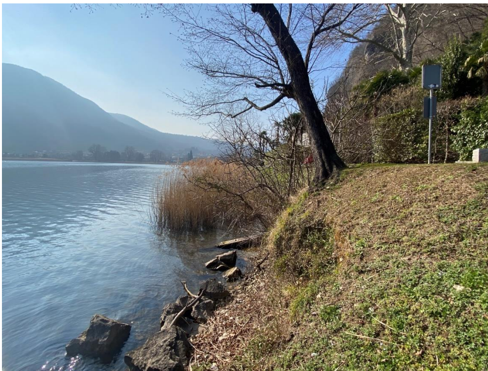
Figura 17: Fotografia albero instabile (lato ovest).
