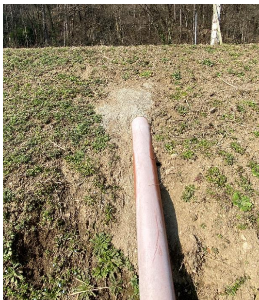
Figura 15: Dettaglio di uno dei tubi affiorati in superficie per il quale si intravede la presenza di un consolidamento in calcestruzzo.
