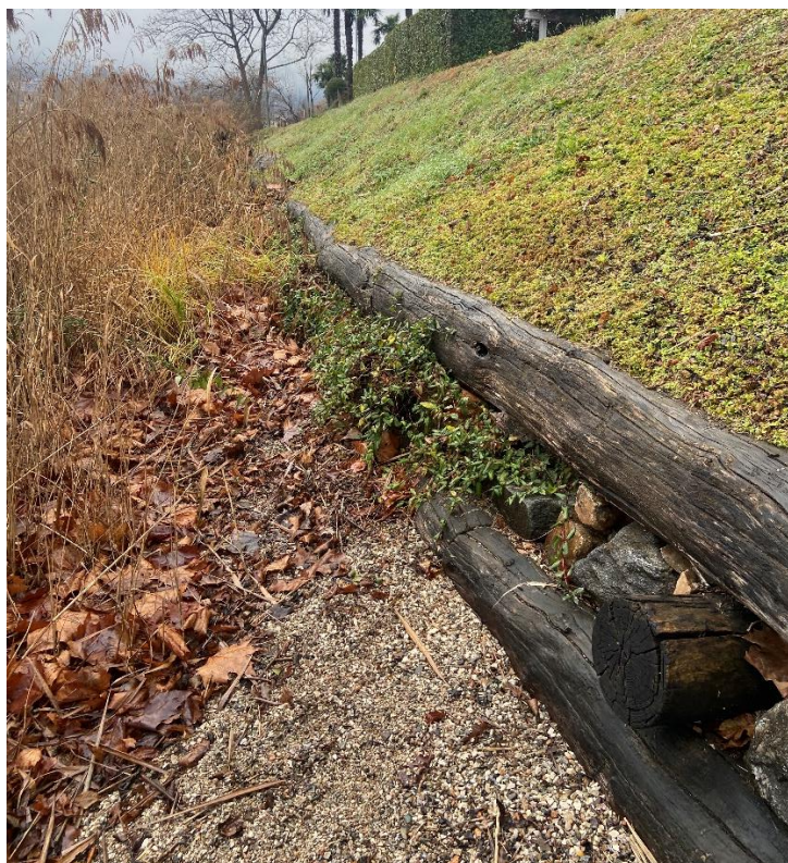
Figura 18: Fotografia del cassone in legno presente a ovest dell'area d'intervento.
