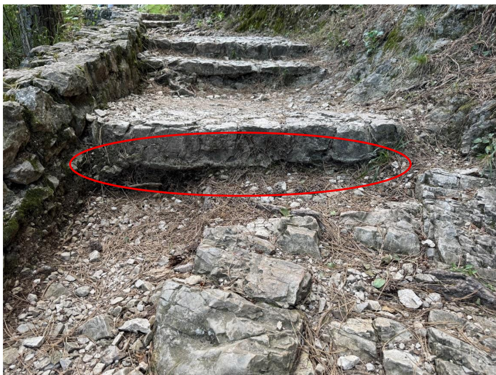
Figura 15: Rifacimento/sistemazione scalino (LS7), Sistemare gradino e posa materiale (2m x 2m x 15 cm).
