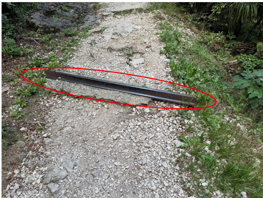
Figura 22: Rimozione canaletta (SRRC4).
