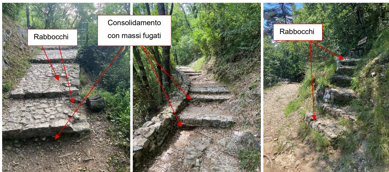
Figura 19: Esempi di interventi sugli scalini lungo il sentiero.
