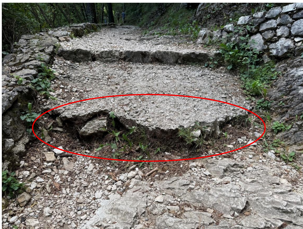
Figura 13: Nuovo scalino (LS5), 1.6 m di larghezza e 30 cm di altezza.
