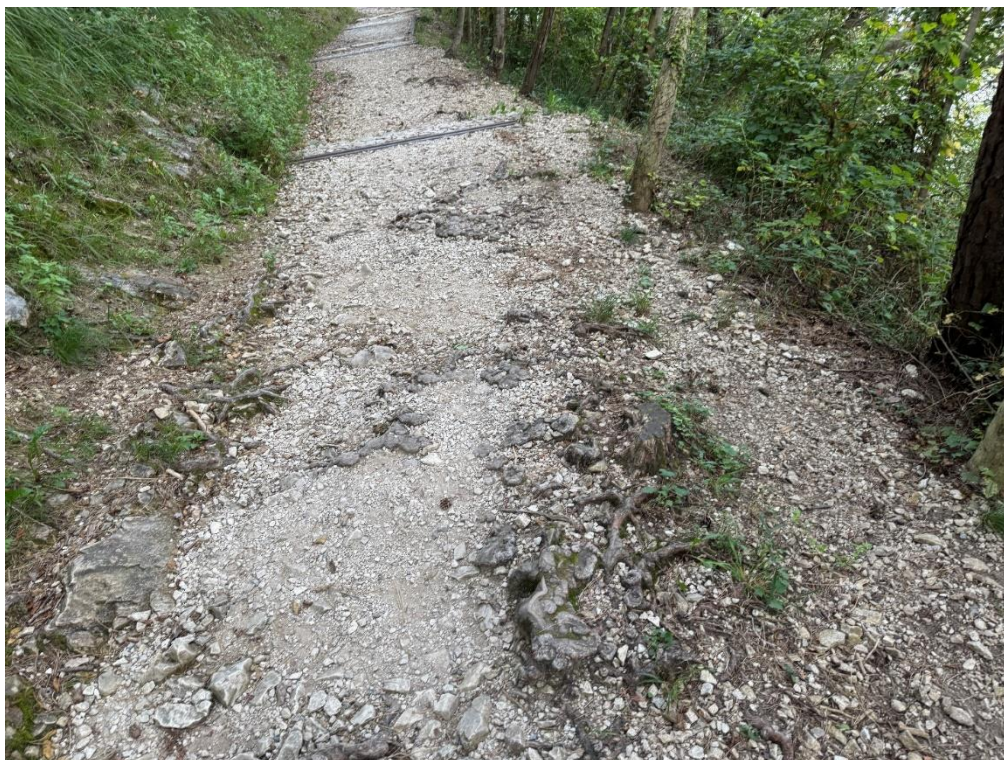
Figura 26: Sistemazione rocce e radici affioranti e aggiunta materiale calcareo.
