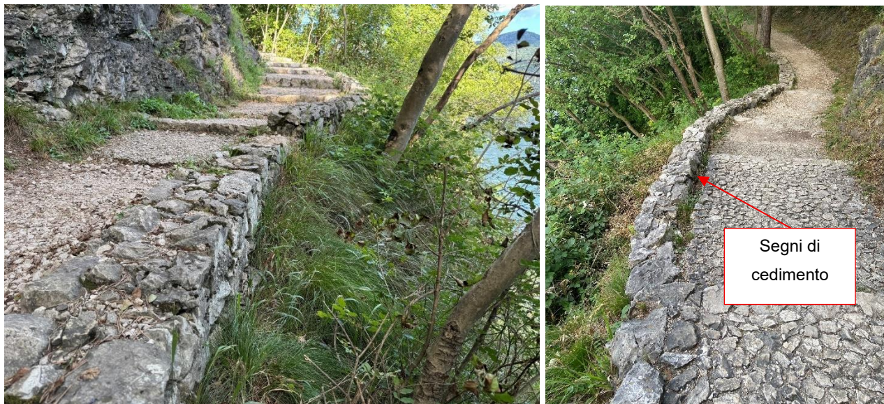
Figura 18: Rifacimento muro (RiM1) di ca. 8 m.
