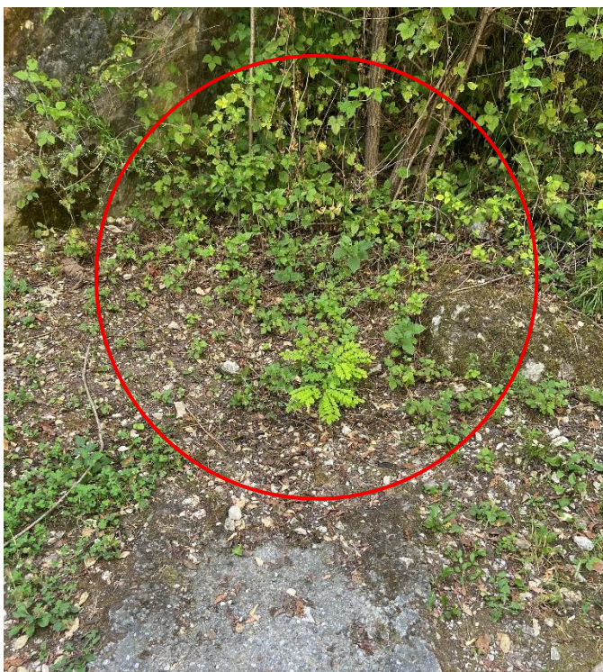
Figura 25: Sistemazione canaletta (SRRC7), Miglioramento invito alla canaletta mediante scavo, taglio di arbusti, spostamento materiale e posa pietre grossolane per indirizzare le acque sul lato sud dell'invito alla canaletta (1.5x1.5m ).
