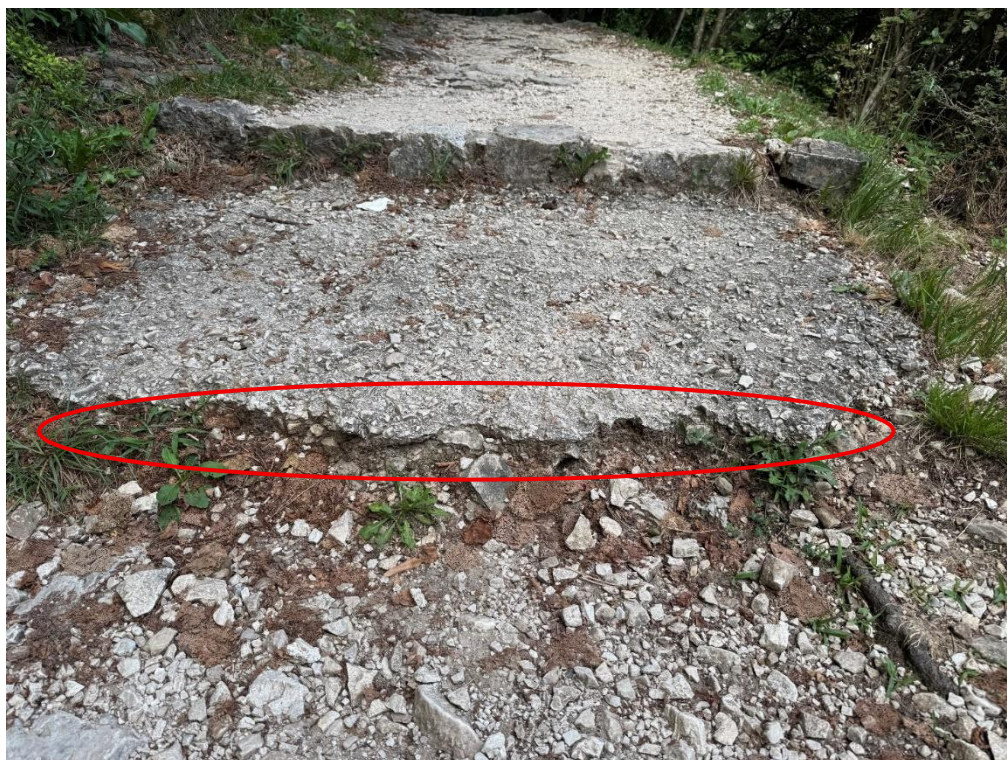
Figura 12: Rifacimento/sistemazione scalino (LS4), con sassi da 20 cm, largo circa 2 m.
