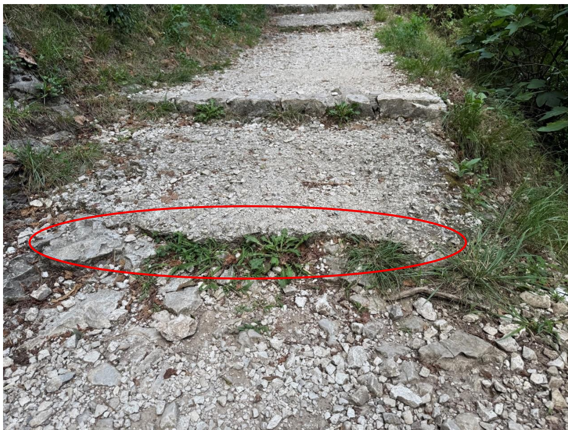
Figura 11: Rifacimento/sistemazione scalino (LS3), con sassi da 20 cm, largo circa 1 m.
