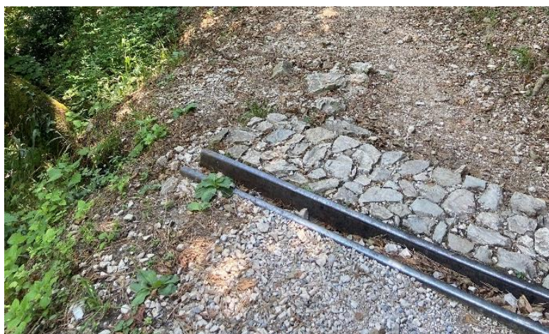
Figura 7: Tipologie di canalette per lo scolo delle acque presenti lungo il sentiero.
