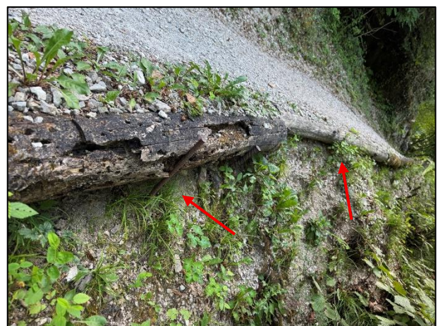
Figura 3: Sostituzione e posa pali doppi. In alcune tratte i pali singoli non sono sufficienti ed è necessario posare dei doppi pali sovrapposti per evitare la sottoerosione e lo svuotamento.
