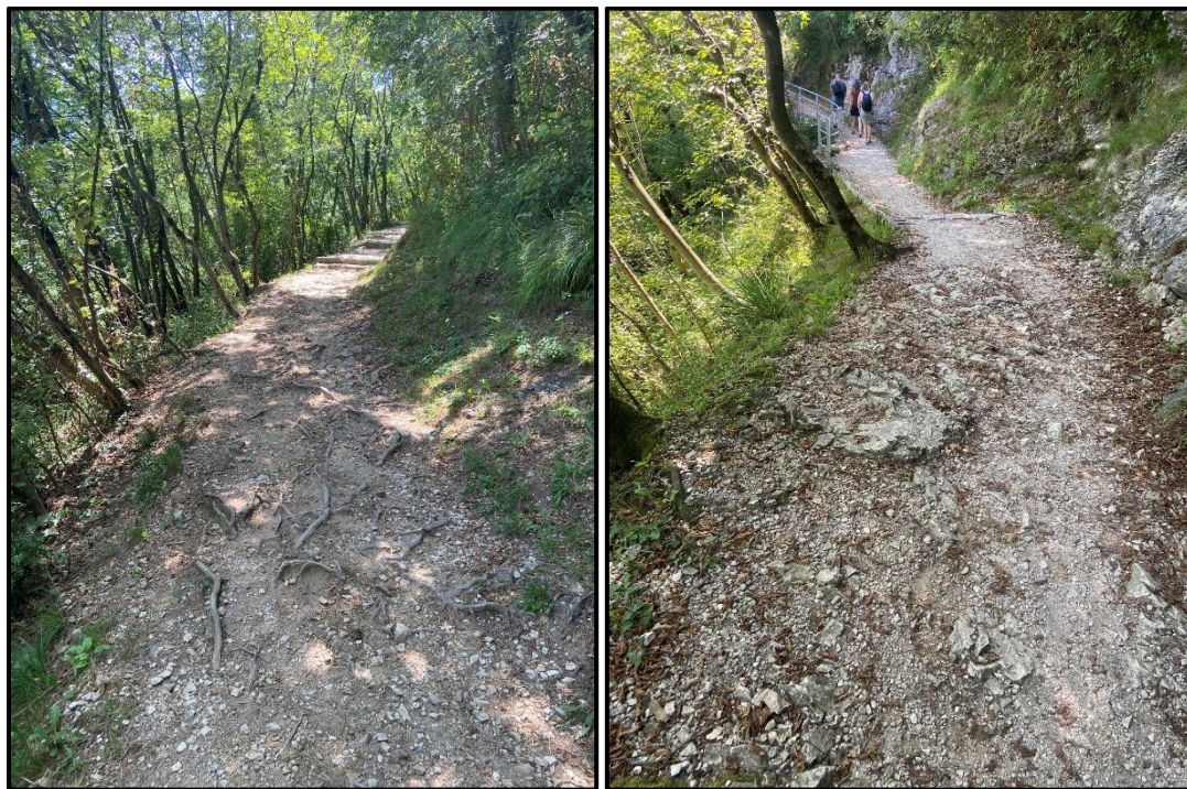
Figura 24: Sentiero caratterizzato da radici o rocce affioranti.
