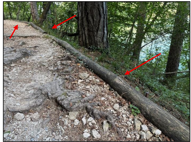
Figura 2: In alcuni casi la sostituzione non è urgente ma dovrà essere fatta nei prossimi anni (ca. 2-5 anni). In caso di intervento si può valutare caso per caso se sostituirli nell'immediato.
