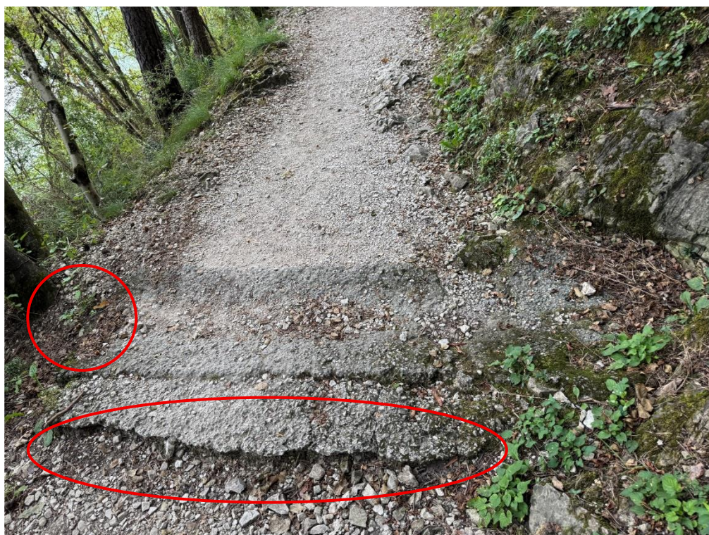
Figura 23: Sistemazione canaletta (SRRC5), posa materiale grossolano alla base della canaletta.
