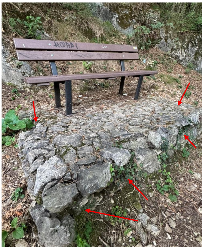
Figura 18: Rabbocco base panchina (RaBP1), Rabbocco puntuale base panchina.
