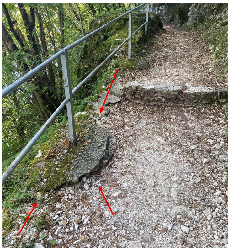
Figura 7: Sistemazione base staccionata (SiBS1), Sistemazione della base della staccionata mediante rabbocchi e posa materiale.
