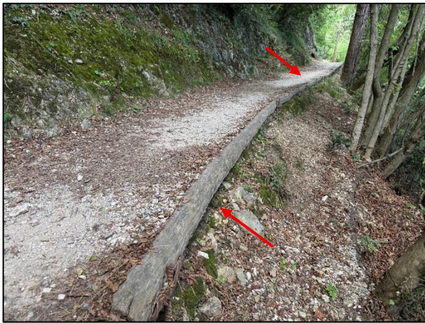
Figura 2: In alcuni casi la sostituzione non è urgente ma dovrà essere fatta nei prossimi anni (ca. 2-5 anni). In caso di intervento si può valutare caso per caso se sostituirli nell'immediato.
