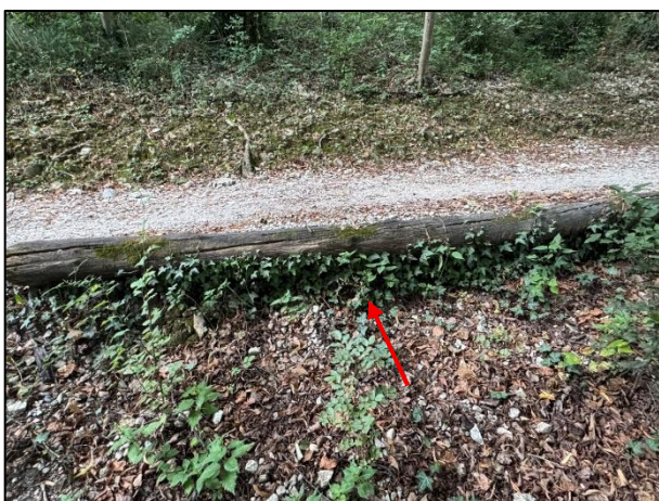
Figura 3: Sostituzione e posa pali doppi. In alcune tratte i pali singoli non sono sufficienti ed è necessario posare dei doppi pali sovrapposti per evitare la sottoerosione e lo svuotamento.
