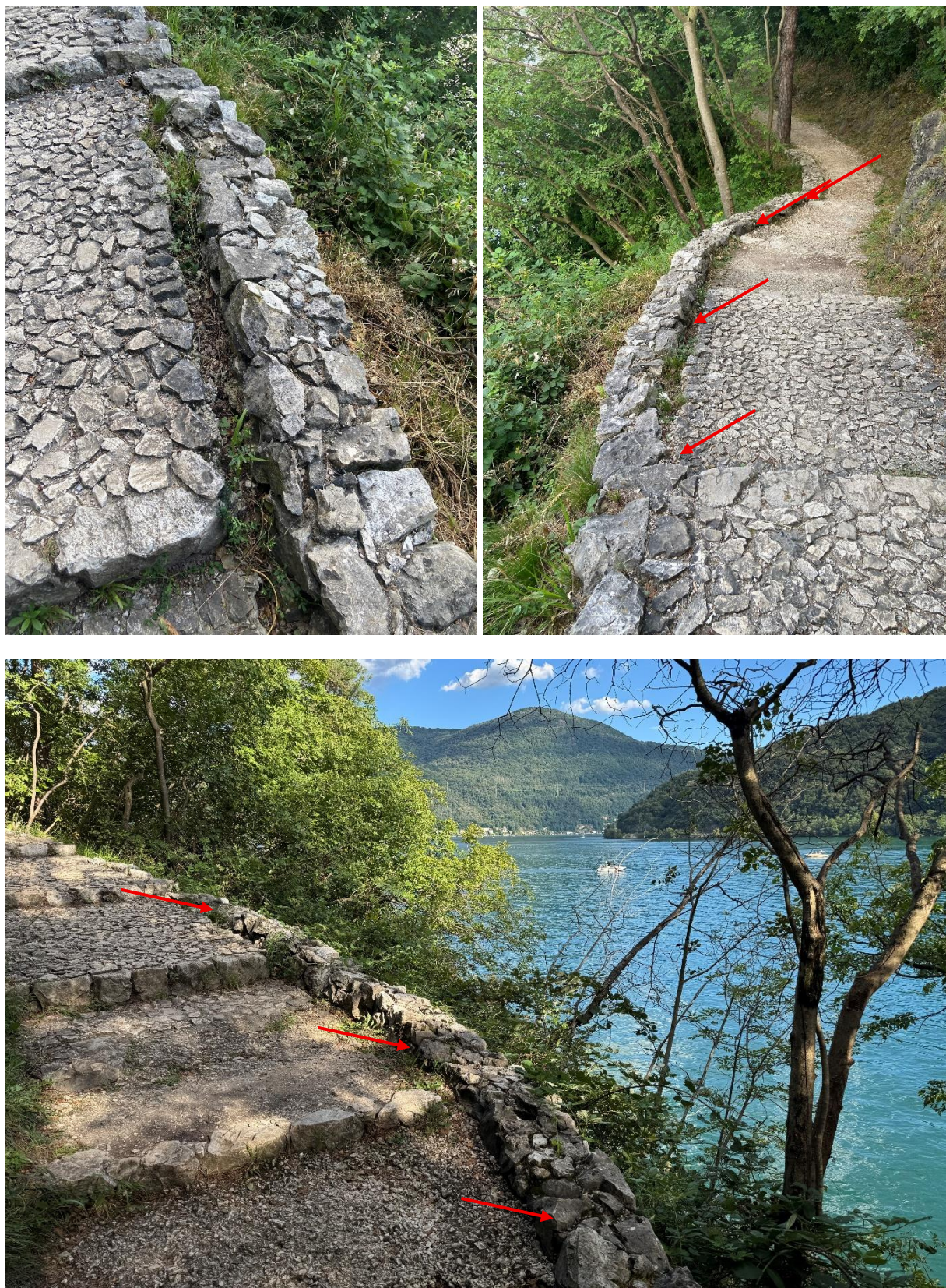
Figura 5: Rifacimento muro (RiM1), Rifacimento di ca. 7-8 m di muro (h= 20-90 cm).
