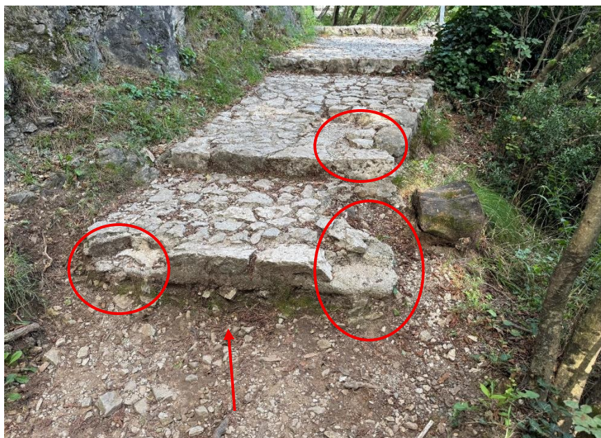
Figura 9: Sistemazione scala (LS1), Sistemazione canaletta e creazione gradino/canaletta.
