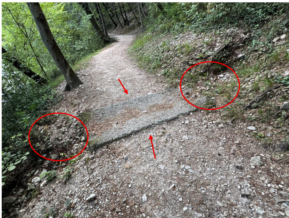
Figura 20: Sistemazione canaletta (SRRC2), sistemazione puntuale invito, e posa massi sotto per erosione.
