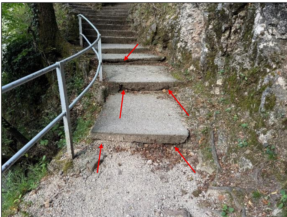
Figura 16: Rabbocchi in calcestruzzo a scala, lievi rabbocchi in calcestruzzo a scala.
