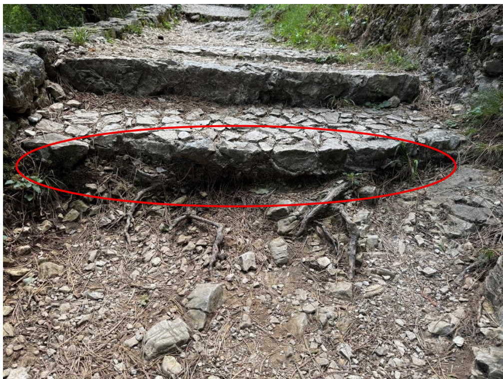
Figura 14: Rifacimento/sistemazione scalino (LS6), pulizia sotto, rinforzare mettendo elementi grossolani, rabboccare gradini.
