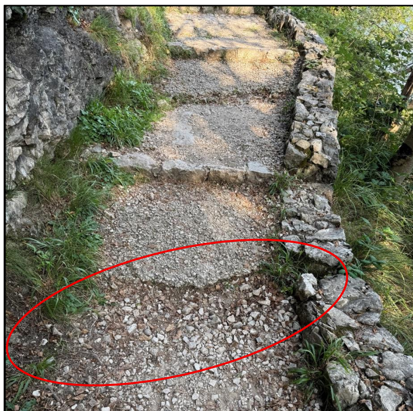
Figura 21: Sistemazione canaletta (SRRC3) e creazione gradino/canaletta.
