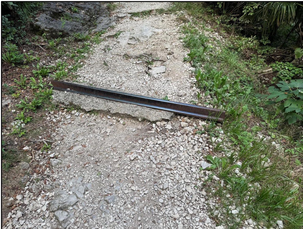
Figura 22: Rimozione canaletta (RiC1).
