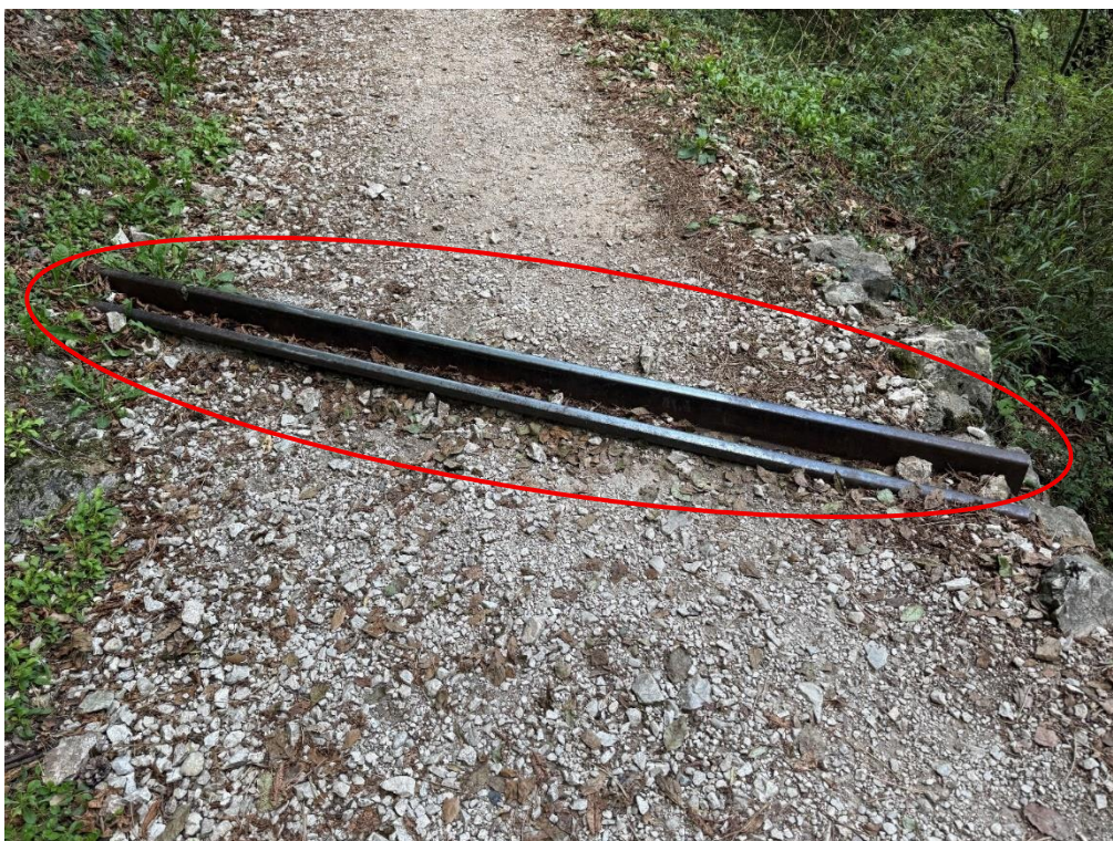
Figura 24: Rifacimento canaletta - posa nuova canaletta (SRRC6), Rimozione dell'attuale canaletta e realizzazione di una canaletta / piccolo travaccone.
