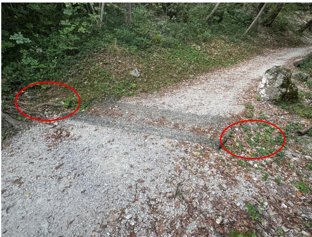
Figura 19: Sistemazione canaletta (SRRC1), Invito a canaletta con piode fugate (sup: 1.5 m x 1.5 m) + taglio di un frassino di 30 cm + posa sassi a valle per evitare erosione.
