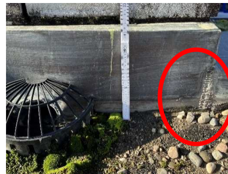
Saldature deteriorate
